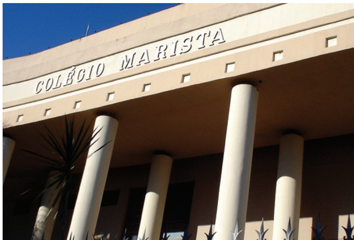
Figura 26 – Detalhe da edificação. Fotografia tomada em setembro de 2006.
