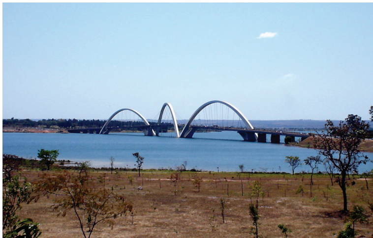
Figura 16 – Ponte JK (Brasília - DF). Fotografia tomada em setembro de 2007.
