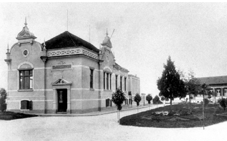
Side view of the Instituto Bacteriológico de São Paulo: in the background, one of the buildings of the Isolation Hospital. In Algumas Instalações do Serviço Sanitário de São Paulo (São Paulo: Vanorden & Co., 1905), Museu Emílio Ribas Collection.
