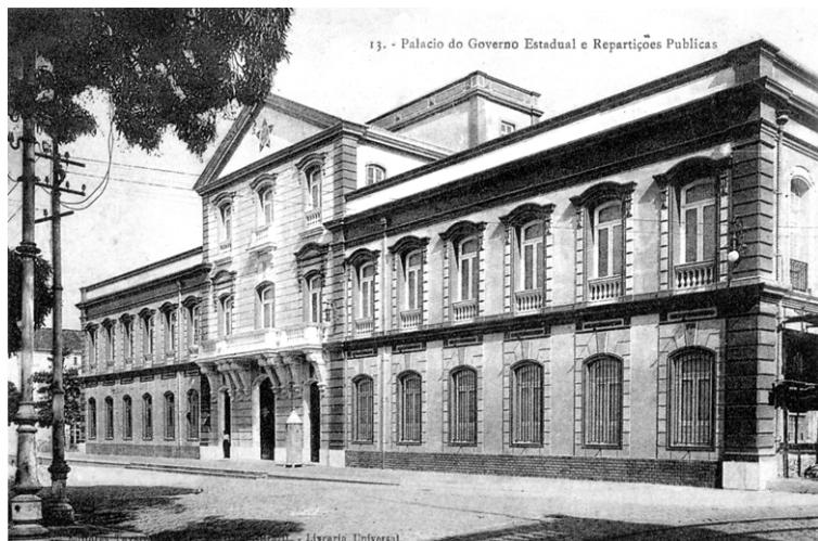
Fachada do Palácio do Governo, após as obras realizadas durante a gestão de Augusto Montenegro, em 1904. Erguido no século XVIII (1771), conforme projeto do arquiteto Antônio José Landi, o prédio recebeu posteriormente o nome de Lauro Sodré e abriga, atualmente, o Museu do Estado do Pará. SILVA e FERNANDES (1998), p.180.
