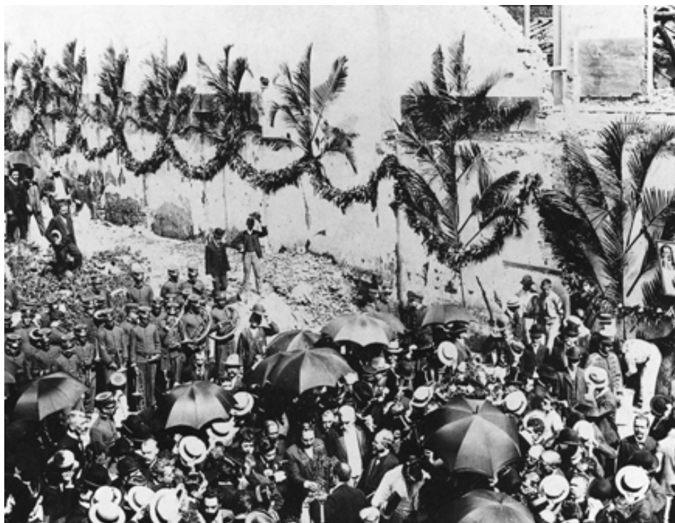
Cerimônia oficial de lançamento da pedra fundamental da Avenida Central, em 8.3.1904. Entre os presentes destacam-se o presidente da República, Francisco de Paula Rodrigues Alves, o engenheiro Paulo de Frontin e o prefeito do Rio de Janeiro, Pereira Passos. A avenida foi inaugurada e entregue ao público em 15.11.1905. Acervo AGCRJ apud MENDONÇA (2004), p.43.
