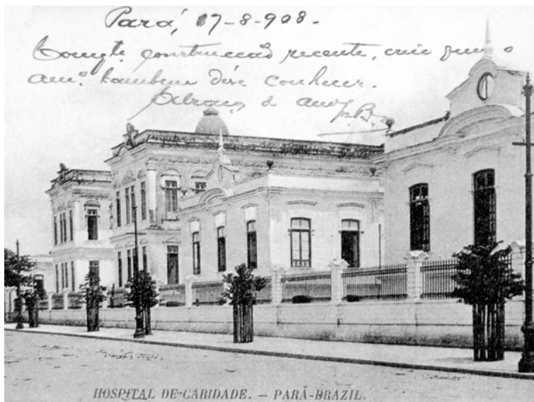
Hospital de Caridade, em Belém, com indicação manuscrita informando a data de 7.8.1908. Os pavilhões eram voltados para a rua Oliveira Bello, entre a avenida Generalíssimo Deodoro e a Travessa Catorze de março. SILVA e FERNANDES (1998), p.192.
