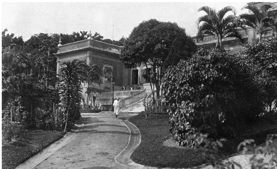
Hospital São Sebastião, fachada do pavilhão central. Rio de Janeiro, 1901-1905 (Acervo Musée de l'Institut Pasteur, PLS29).
