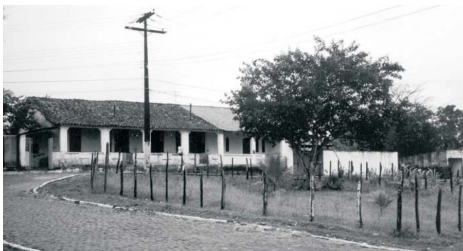
FOTO 2 - Habitação dos técnicos da Usina Cinco Rios
