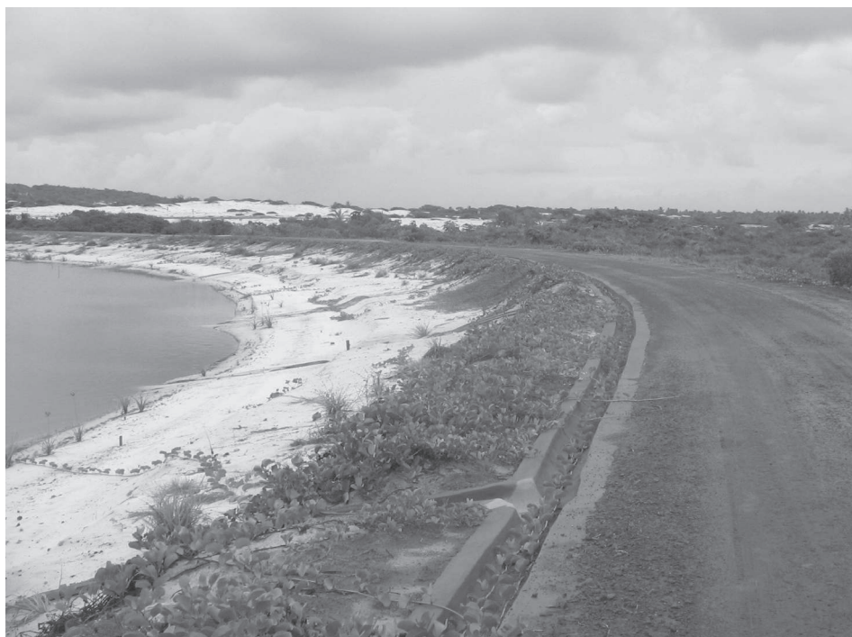
Barragens construídas para perenização da laguna
