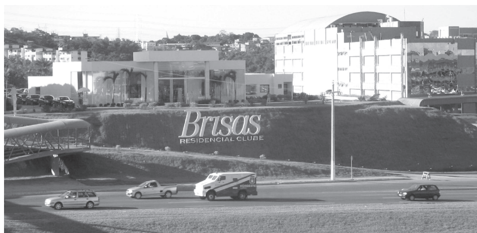
Obras de vários empreendimentos na região do Alphaville / Salvador
