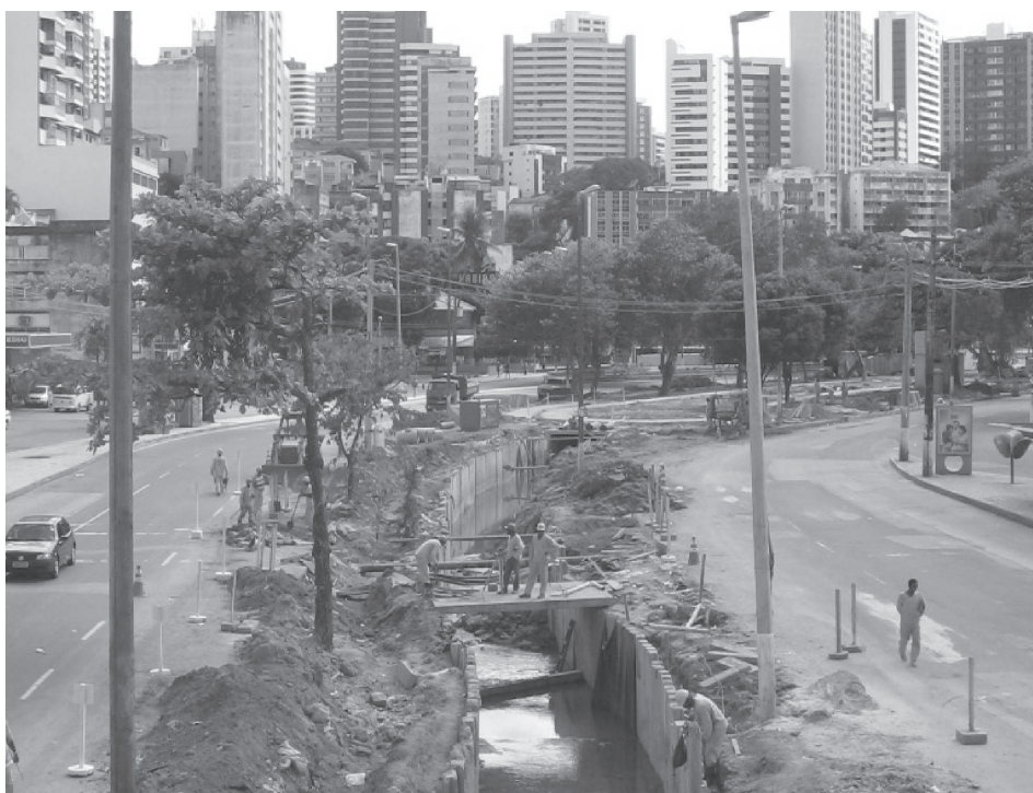
Canalização do Rio dos Seixos (Avenida Centenário) em Salvador (ago/2008). Apesar do discurso sobre a natureza na cidade, elementos naturais não desejáveis são escondidos.
